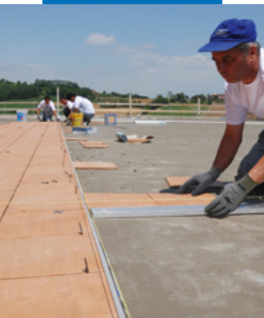
Instalarea plăcilor ceramice cu Kerabond + Isolastic
