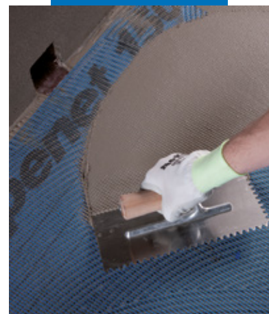
Aplicare Mapelastyc pe Mapenet 150
