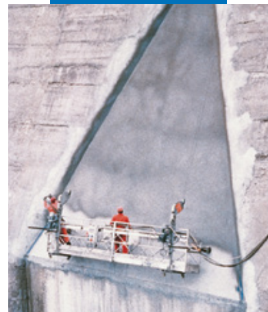
Exemplu de aplicare Mapelastic prin pulverizare la un baraj
