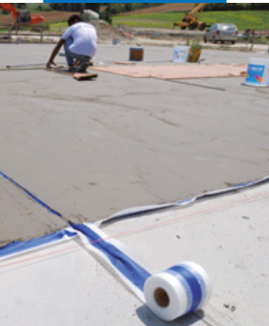
Hidroizolarea șapelor cu Mapelastic și Mapeband
