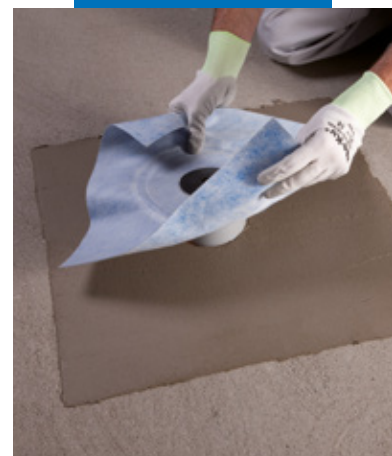
Montarea elementului de scurgere, Drain Vertical, pe Mapelastyc
