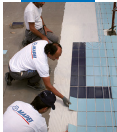
Punerea în operă a plăcilor ceramice pe hidroizolația Mapelastic
