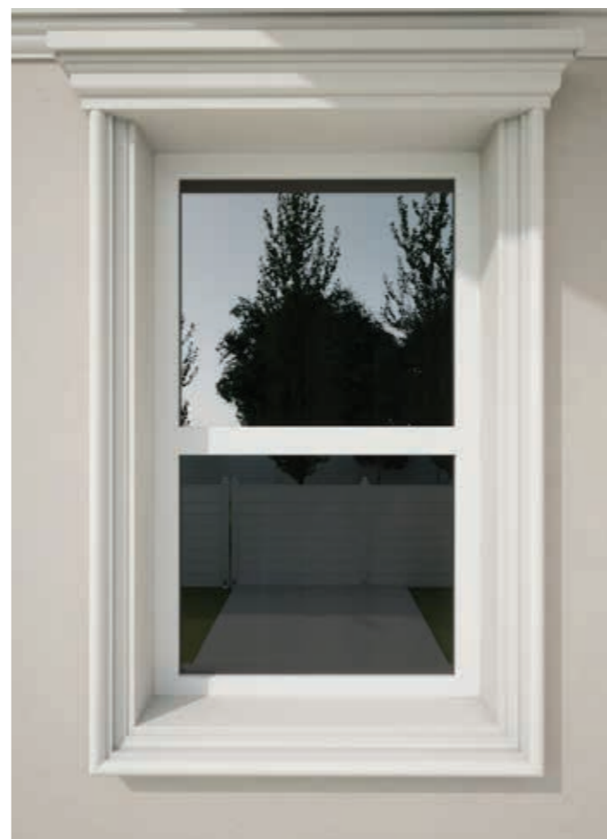
EX03 Ancadrament cu solbanc sus Ancadrament FP114 și solbanc FP206
